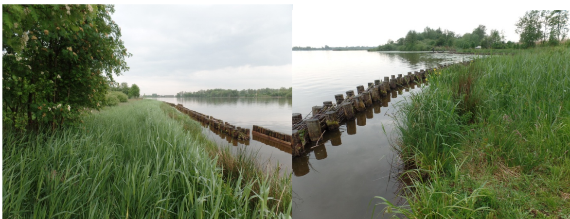
Figuur 2.12 & 2.13: huidige situatie van de rietkraag aan de zuidkant van de Schuurwerf. Nvo bestaande uit voornamelijk riet met aangelegde golfbreker.
